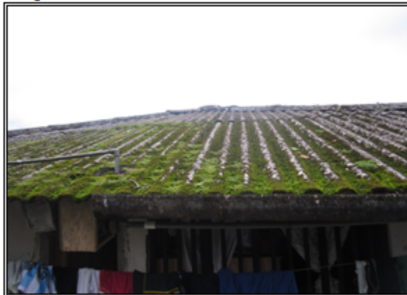
Figura 5. Techo en asbesto utilizado en las viviendas
